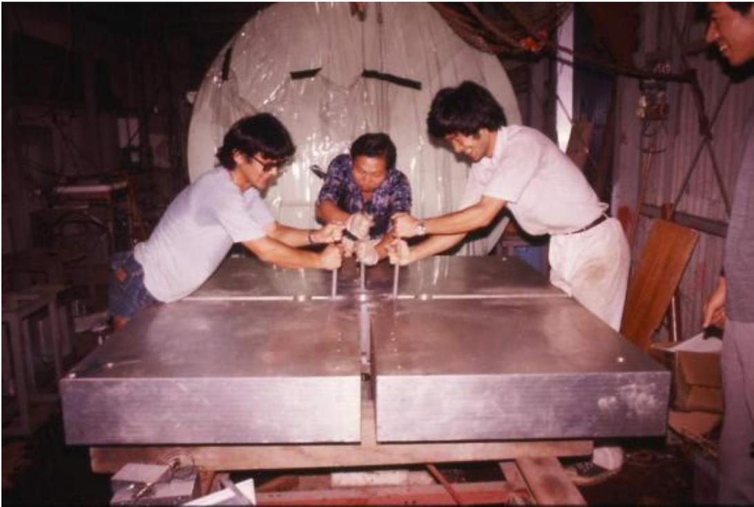
金ヤスリを使ってアンテナの切込みを削る
